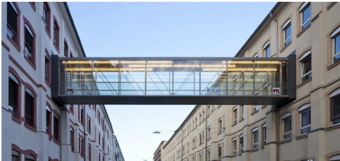
Abb. 67: Die beiden Gebäude wurden durch eine filigrane Stahlkonstruktion miteinander verbunden (Foto: ATELIER ALTENKIRCH 2010)
