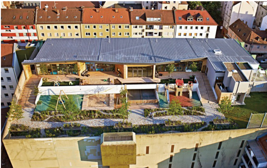
Abb. 82: Die Brücke verläuft im 3 OG (Foto: INA KINDERGARTEN 2022)
